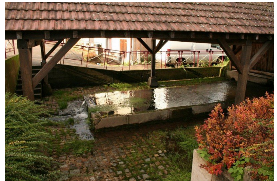
7. Le sol est pavé sur tout le pourtour.
