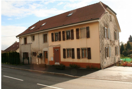
10. Construction ancienne modernisée et utilisée à des fins d'habitation
