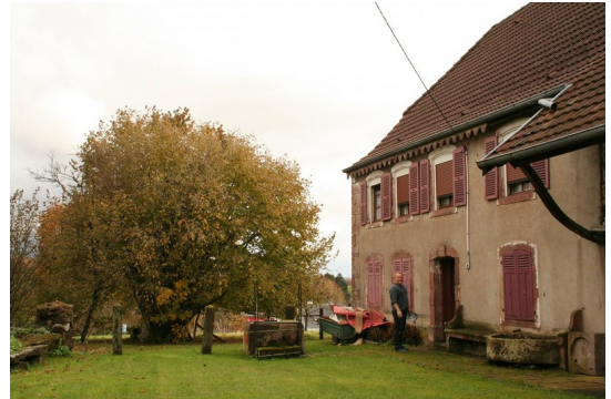
16. Construction ancienne ayant conservé l'essentiel de sa volumétrie et de ses ouvertures d'origine, sans remaniements dommageables
