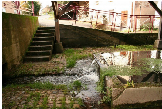
7. En contrebas de la route, on y accède par un escalier.
