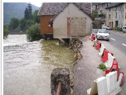
Érosion de berges à Lods (25) - 2006 (Source DLA)
