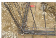
Noeud de chaînage - Continuité mécanique
