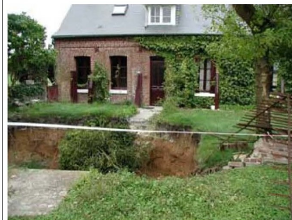
Conséquence d'un affaissement (Somme) – (Source : BRGM)
